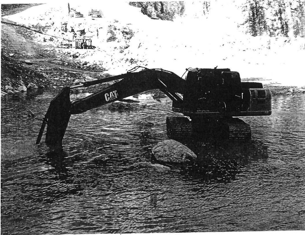
ภาพที่ 1.2 การขุดลอกบ่อดักตะกอน
