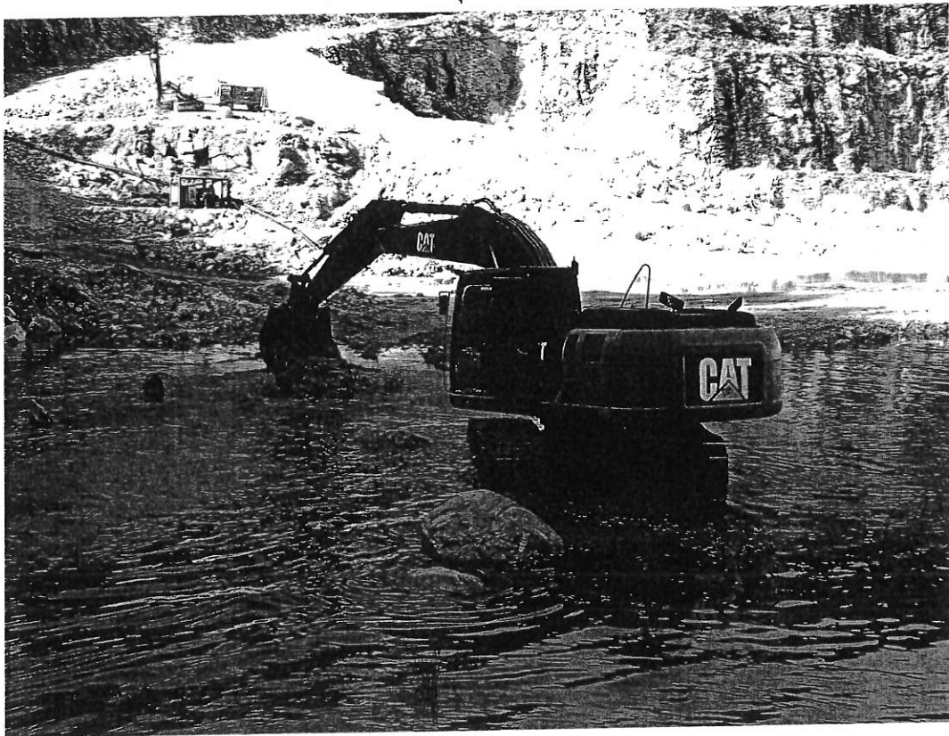
ภาพที่ 1.2 การขุดลอกบ่อดักตะกอน
